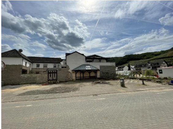
Dorfplatz der Ortsgemeinde, welcher durch die Flut stark in Mitleidenschaft gezogen wurde und nun wiederaufgebaut wird (vgl. Kap. 5.3.1)
