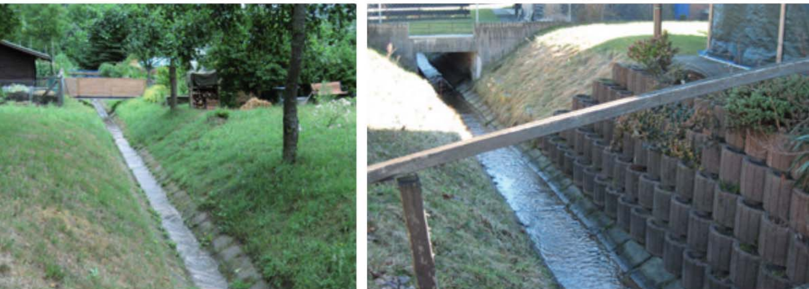
Abb. 15: Übergangshilfe und Einengung des Abflussquerschnitts
