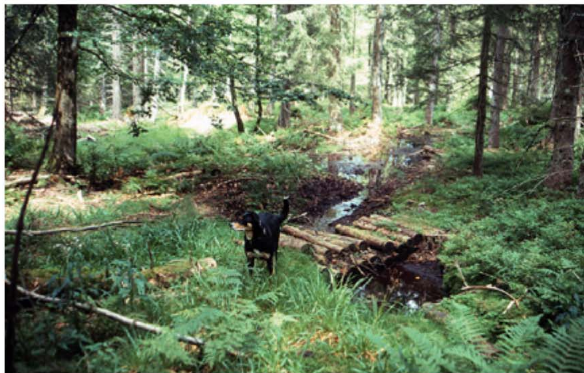
Abb. 29: Wiedervermässung eines ehemaligen Grabensystems in den Hochlagen des Südschwarzwaldes zum Zeitpunkt der Einrichtung (oben) und nach fünf Jahren (unten)
