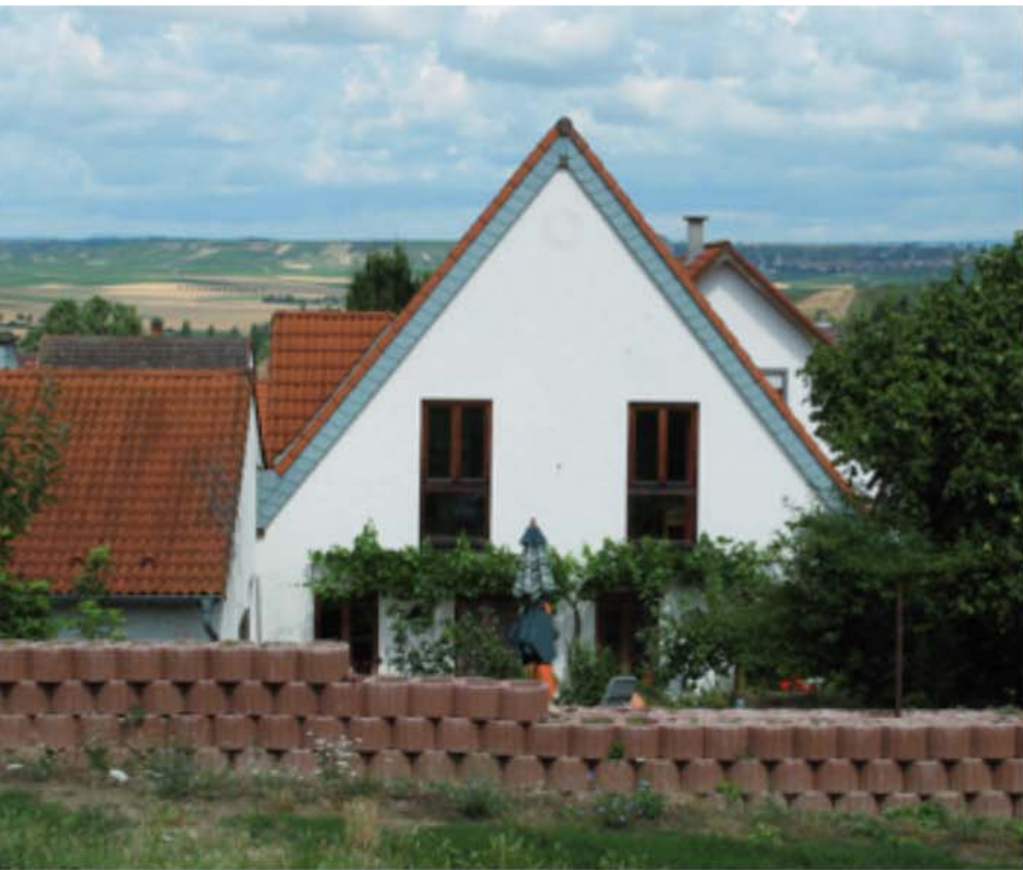
Abb. 34: Mauer aus Flora-Wall-Steinen zum Schutz vor Außengebietswasser
