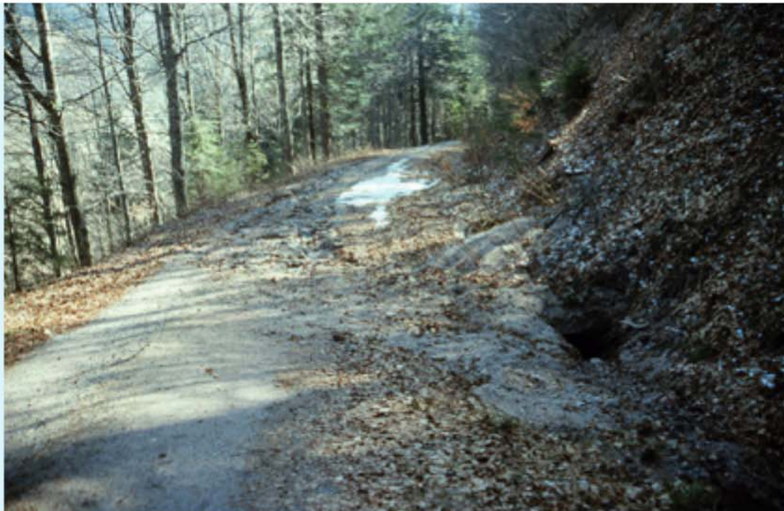
Abb. 30: Auffüllung der bergseitigen Böschung vor dem Doleneinlauf
