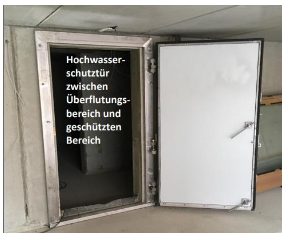
Hochwasserschutztür Durchflutbare Außentreppe
