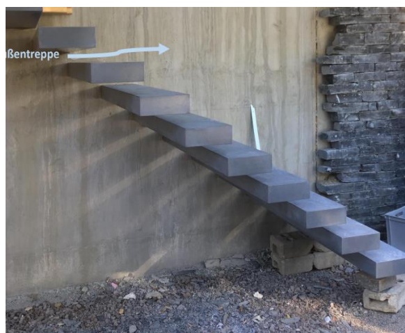
Hochwasserschutztür Durchflutbare Außentreppe
