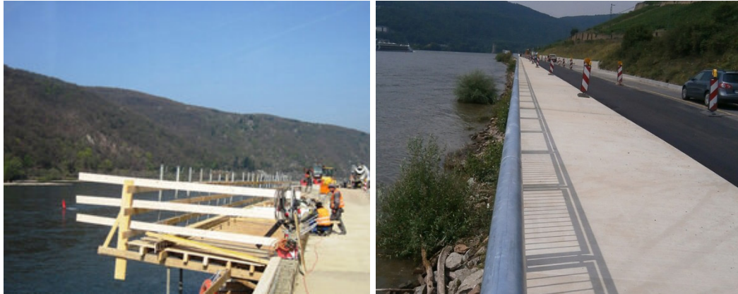
Abbildung 8 Freistehende Unterkonstruktion Rheinradweg Quelle: https://www.meyer-bauen.de/projekte/details/geh-und-radweg-entlang-der-b-42.html .
