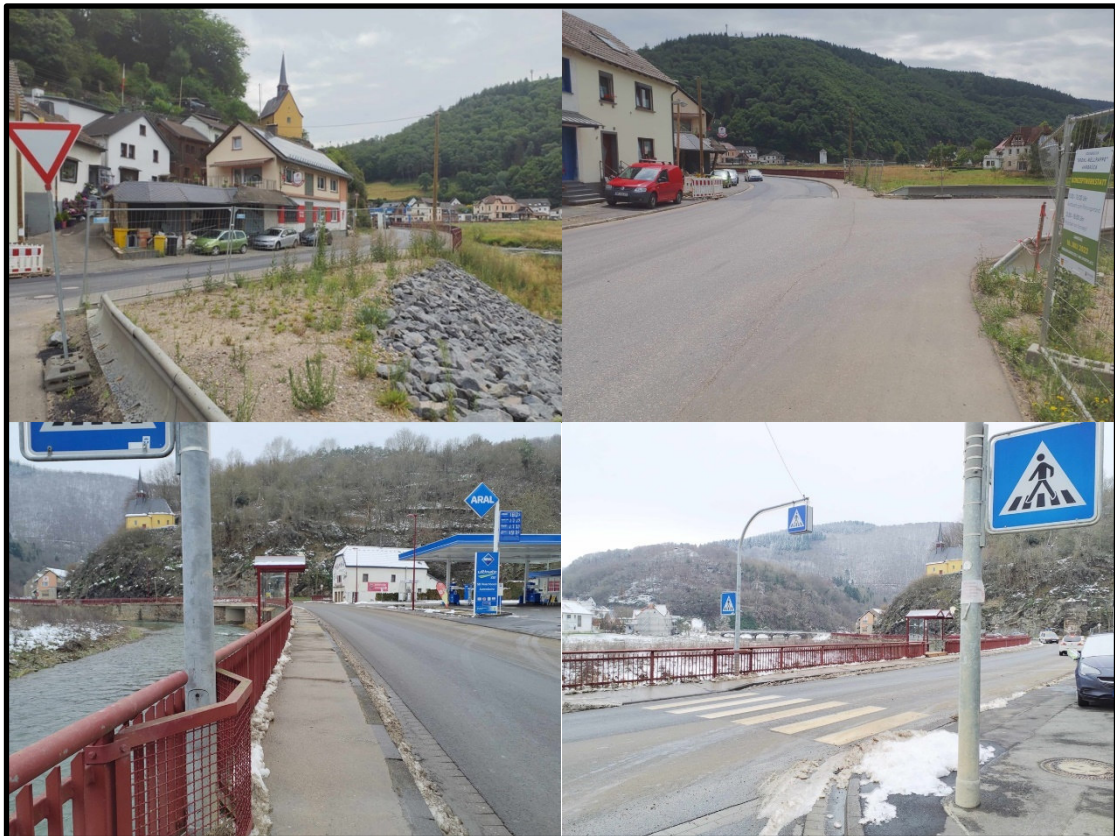
Abbildung 2 Bestandssituation, Bilder Oben Kreuzung B 257/ Linder Straße und Bilder Unten Kreuzung B 257/ Sudetenstraße.
