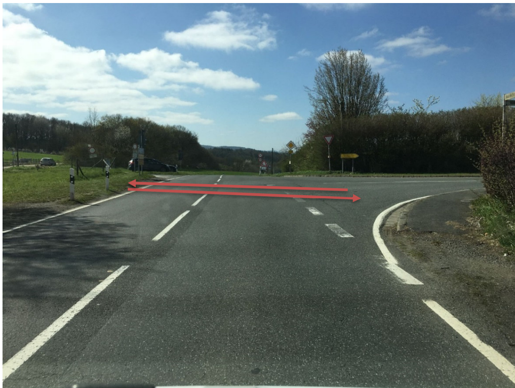
Foto 1: Bestandssituation Kreuzungsbereich B 257; Quelle: https://www.mapillary.com/app/?lat=50.54646785375695&lng=7.004447858787103&z=18.21129750454523&pKey=1391505184537924&focus=photo
