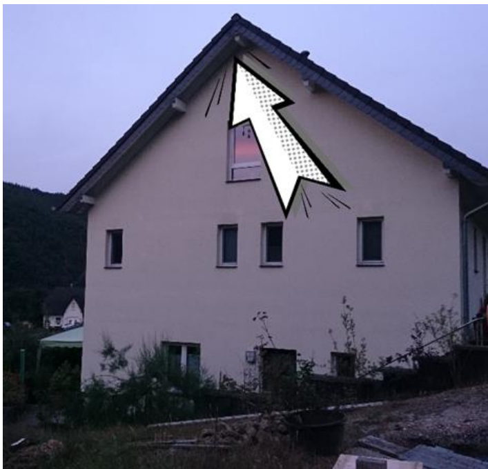
Abbildung 11: Wochenstubquartier im Giebelbereich des Hauses Kapellenstraße 61
